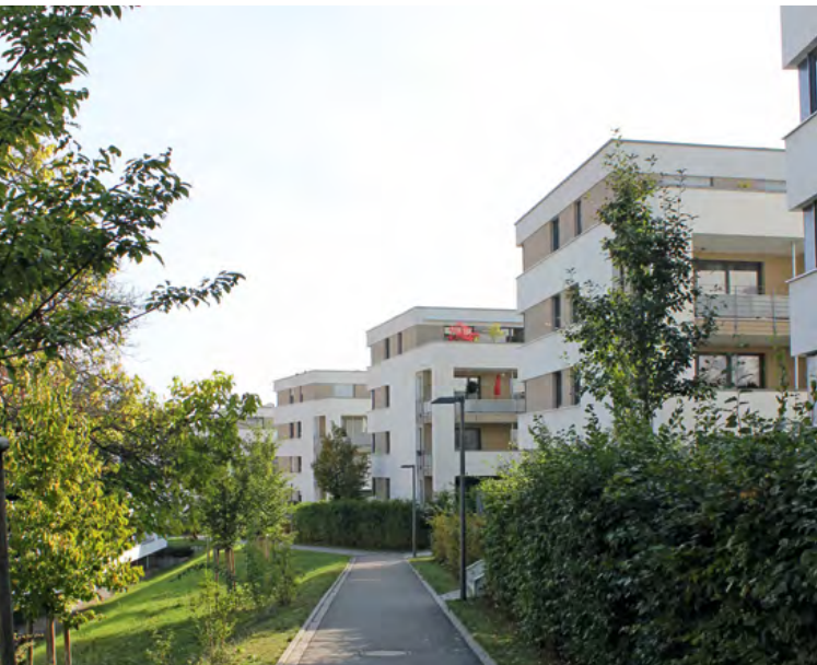
Wohnbebauung Feuerbacher Balkon, Stuttgart
