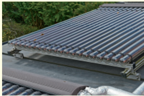
Vakuümrohrenkollektor
