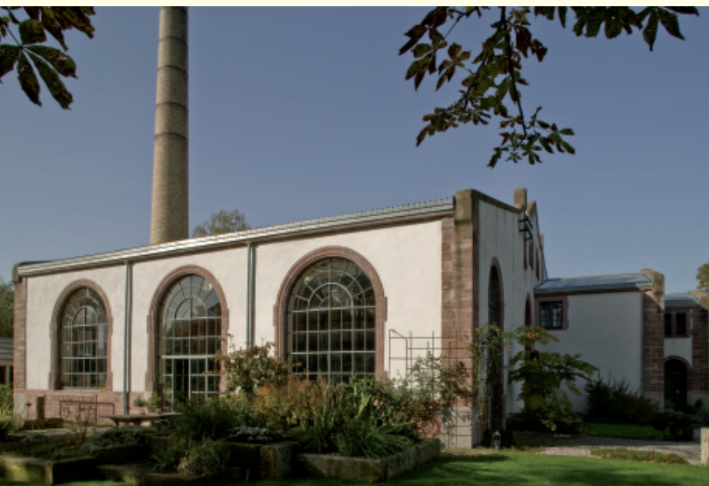
Südostfassade mit Metallrundbogenfenstern und Sandsteineinfassungen
