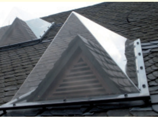
Luftkollektoren über den Dreiecksgauben der Süddachfläche
