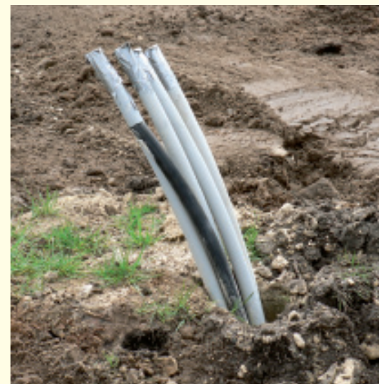
Erdwärmesonde
