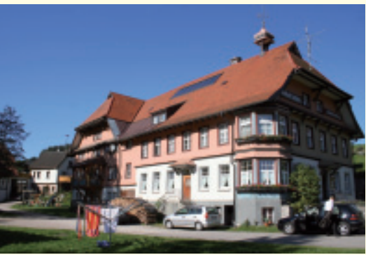
Kleine Kollektorflächen als Indachanlagen erleichtern die Einbindung in das Erscheinungsbild eines Gebäudes.
