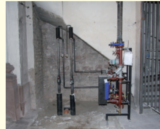
4 Fernwärmeübergabe unter der Empore
