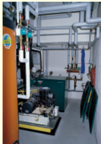
Kraft-Wärme-Kopplung im Kleinen, der Dachs
