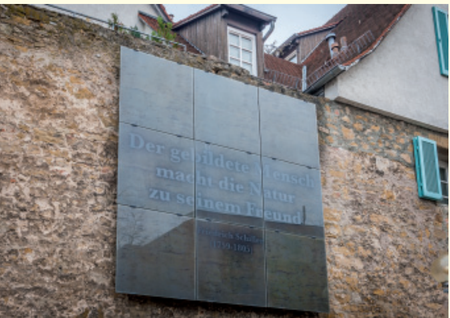
Denkmalgeschützte Stadtmauer mit Dünnschicht-Photo- voltaikanlage
