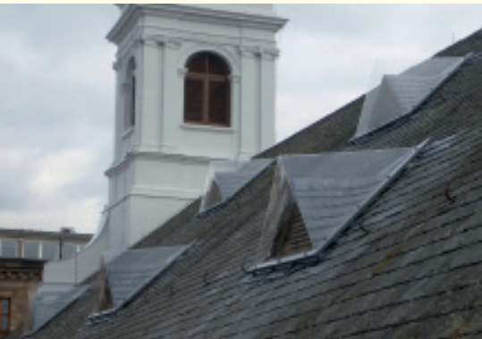
Luftkollektoren über den Dreiecksgauben der Süddachfläche
