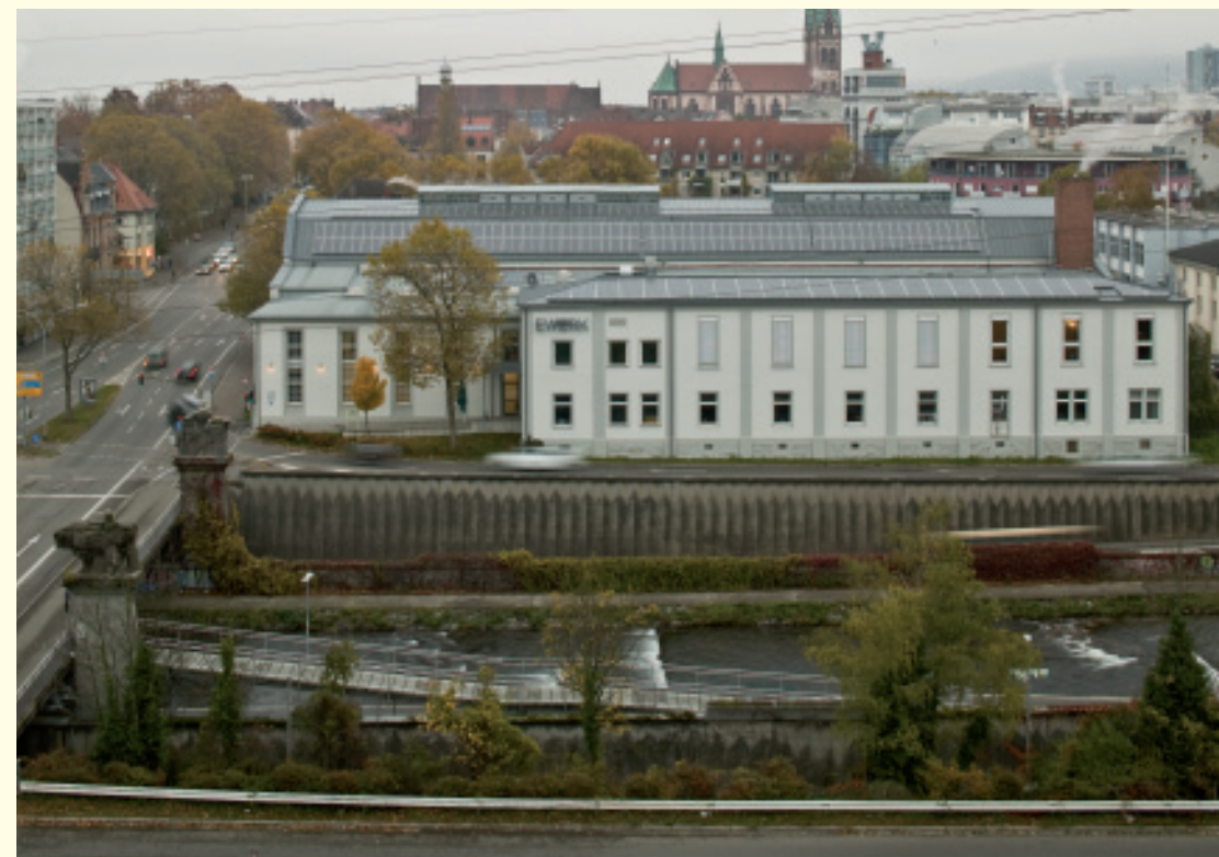
Die Photovoltaikanlagen schreiben die bauzeitliche Nutzung der Halle als Elektrizitätswerk weiter.
