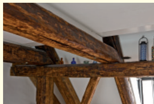
Ausgebautes Dachgeschoss mit mittelalterlichem Dachstuhl
