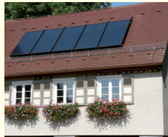
Solarkollektoren treten häufig dunkel und unstrukturiert in Erscheinung.
