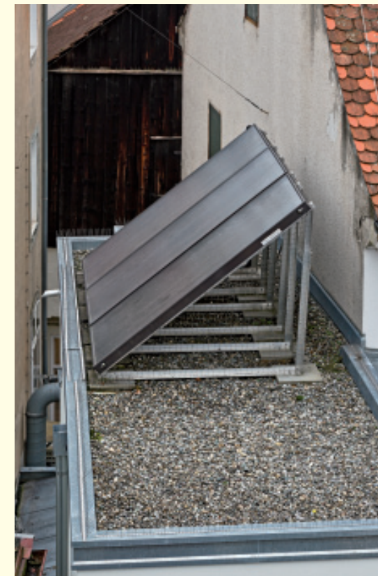
Solarthermischer Flachkollektor
