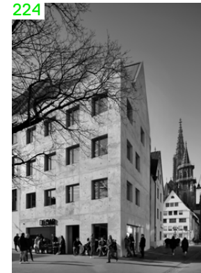
Nachher: ein multifunktionaler Stadtbaustein
