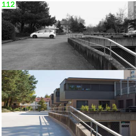
P Konstanz, Wohnen statt Parken (→ 19): Neue Wohngebäude auf dem Bestandsparkdeck
