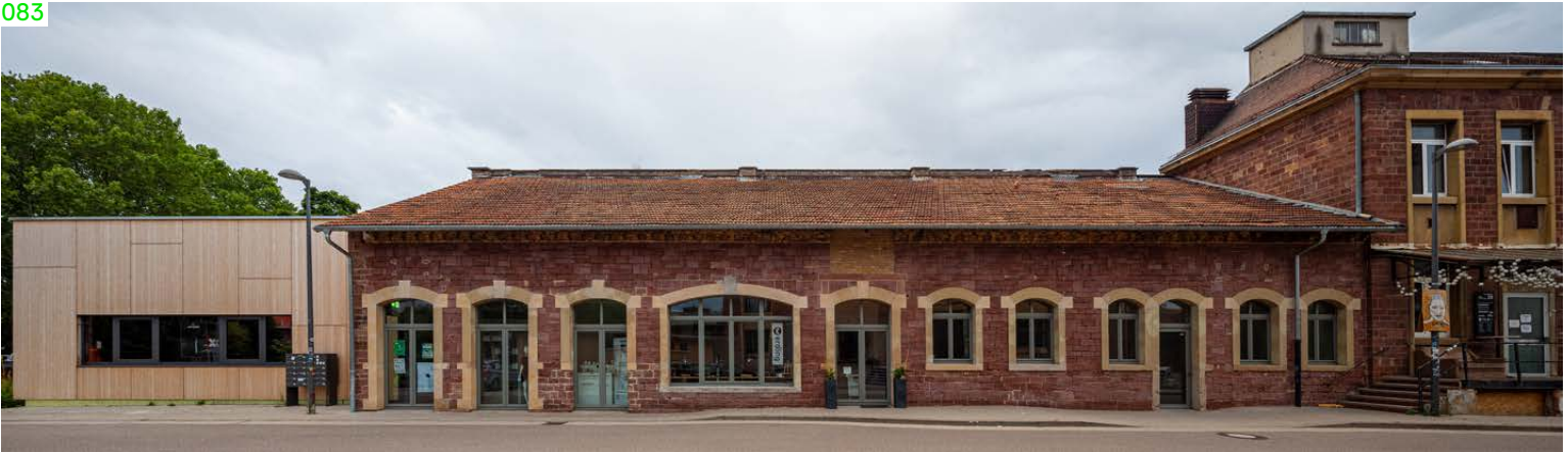
L Karlsruhe, Alter Schlachthof (→ 15): Alte Großmarkthalle – heute Kunsthandwerkerzentrum
