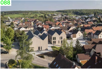
M Walzbachtal, Neubau Rathaus Wössingen mit Rathausplatz (→ 36): Der Neubau stärkt die Ortsmitte
