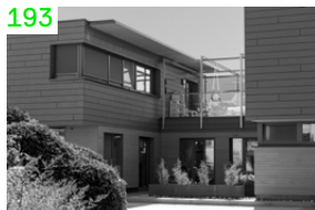
Gebäude in Holzfertigbauweise mit Anschluss an bestehendes BHKW
