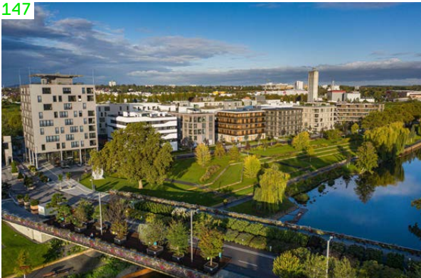
U Heilbronn, Stadtquartier Neckarbogen (→ 14): Neckarpark mit Holzhochhaus SKAIO
