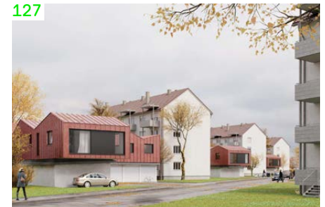
R Patenschaft Innovativ Wohnen BW (→ 2): Garagenaufstockung, Volkswohnung GmbH Karlsruhe
