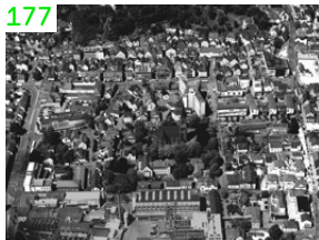
Das Ploucquet-Areal vor der Neubebauung (2011)
